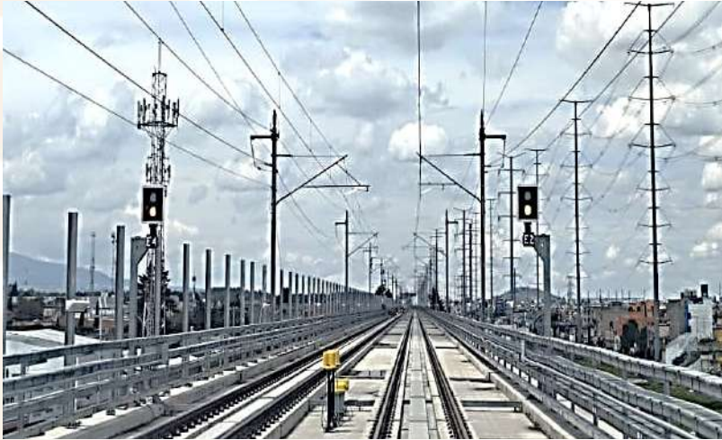
Puesta en marcha señalización
