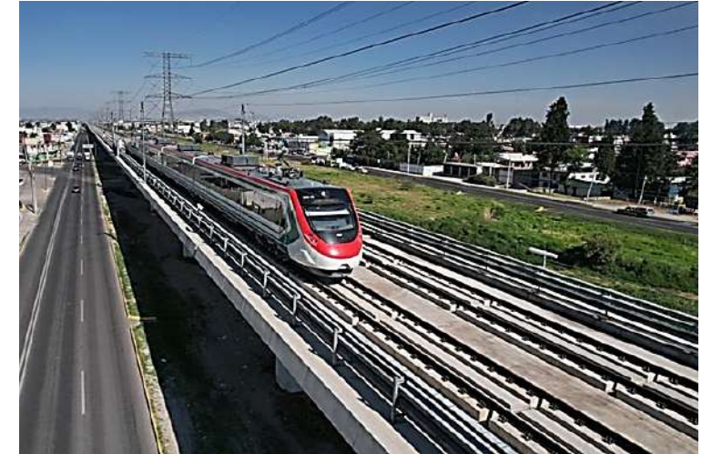
Pruebas de conjunto de trenes, vía y catenaria
