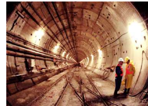
Bi-Túnel de 4.7 km
