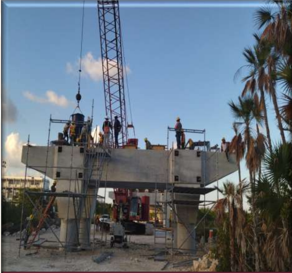
Puente Vehicular Nichupté
